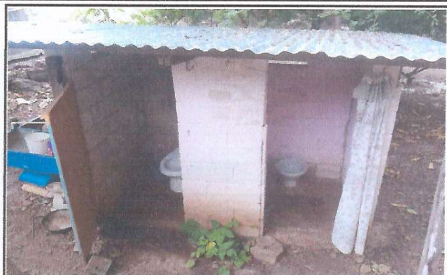
Foto 2: MEJORAMIENTO DE SERVICIOS SANITARIOS Y SUS ACCESORIOS.
