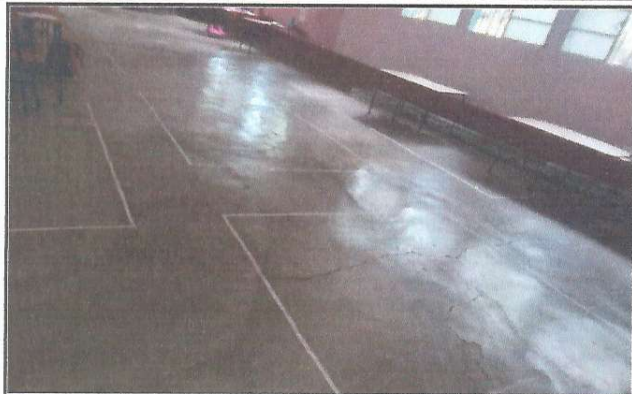
Foto 1: MEJORAMIENTO Y SUSTITUCIÓN DE PISO
