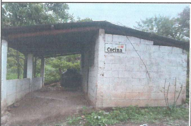
Foto 3: REPARACIÓN O SUSTITUCIÓN DE ÁREA DE COCINA.
